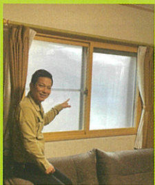
↑自身で設置した内窓
