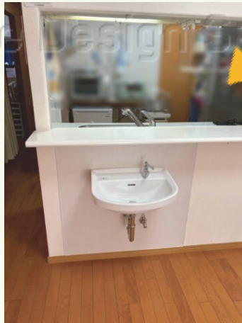
④壁掛け洗面器を取付け、車いすで使い心地を確かめて完了です
