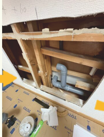
②配管を分岐します
